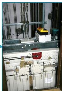
Modul BOS-M služi na predčasné otváranie kabínových dverí
